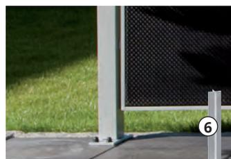
Pfosten einbetonieren oder kürzen und mit Träger Aluminium-Hohlpfosten aufschrauben
