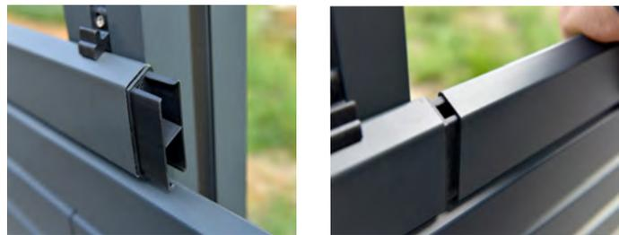
Einfache Montage mit Befestigungsclip und Längsverbinder
